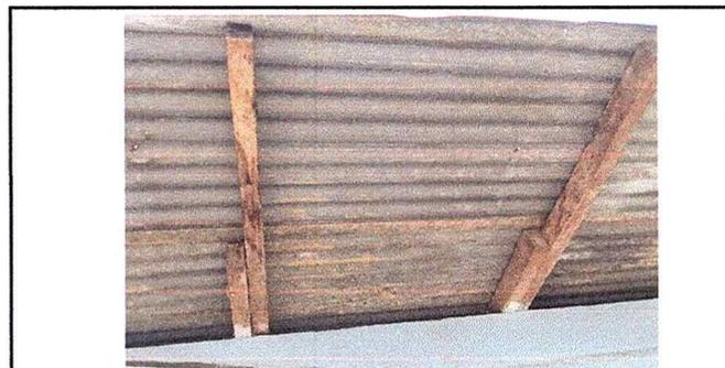
Foto 6: Vista interio de techo y cubierta de lamina con necesidad de cambio.
