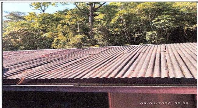
Foto 1: Vista frontal de módulo 1 en donde se puede notar el techo en mal estado.
