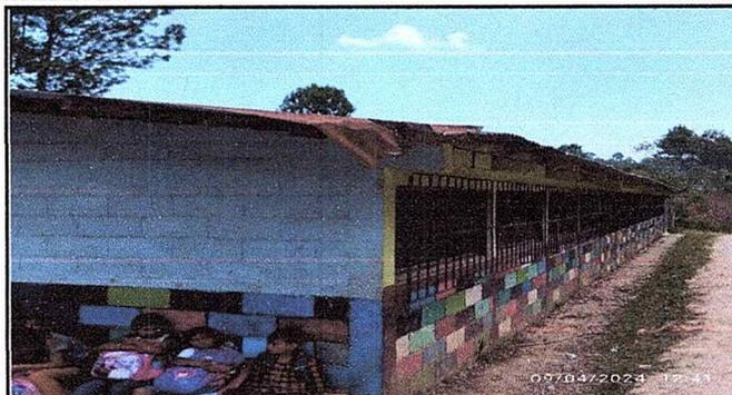
Foto 2: Vista desde la parte Norte en donde se observa que el techado esta dañado y las ventanas sin vidrios
